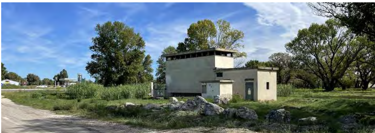
Vue de la station de relevage des eaux pluviales
