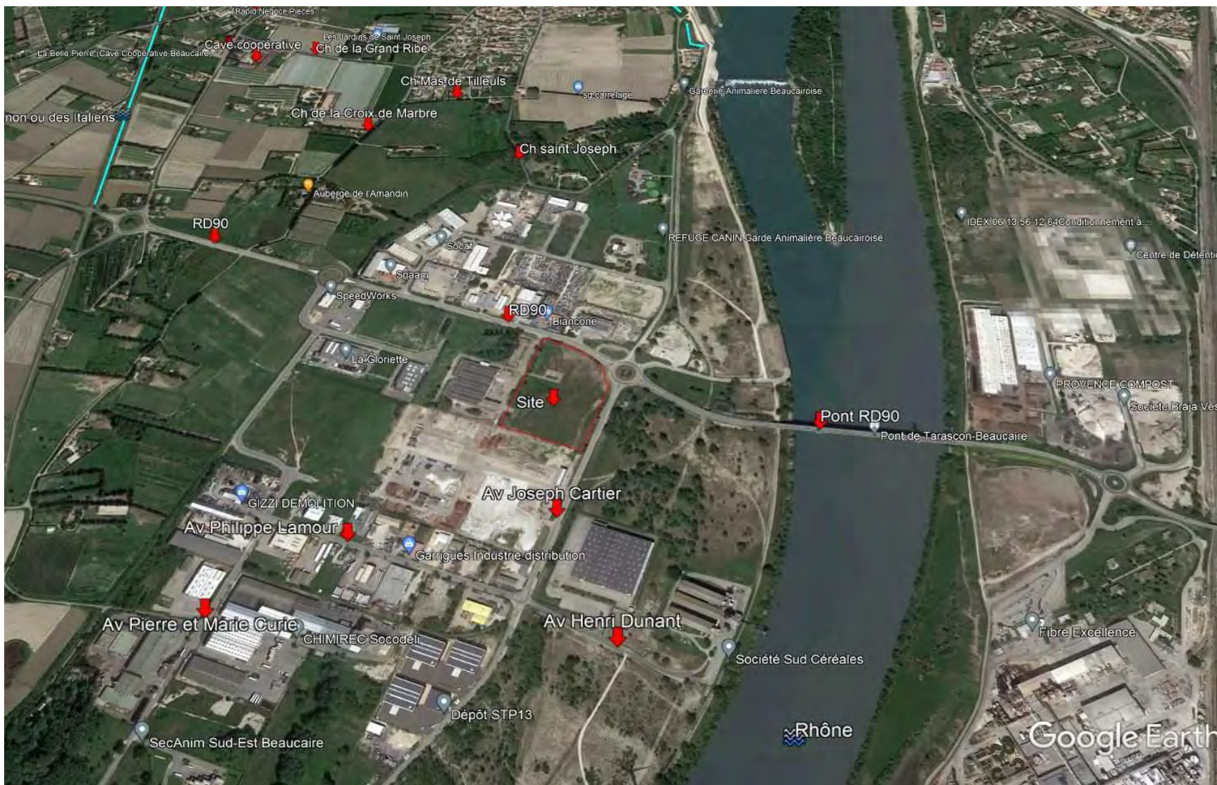
Localisation du site d'étude - Source Google Earth
