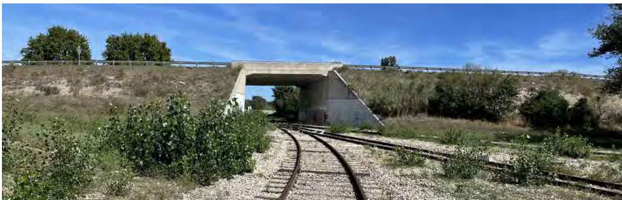
Vue du passage ferré sous la RD90
