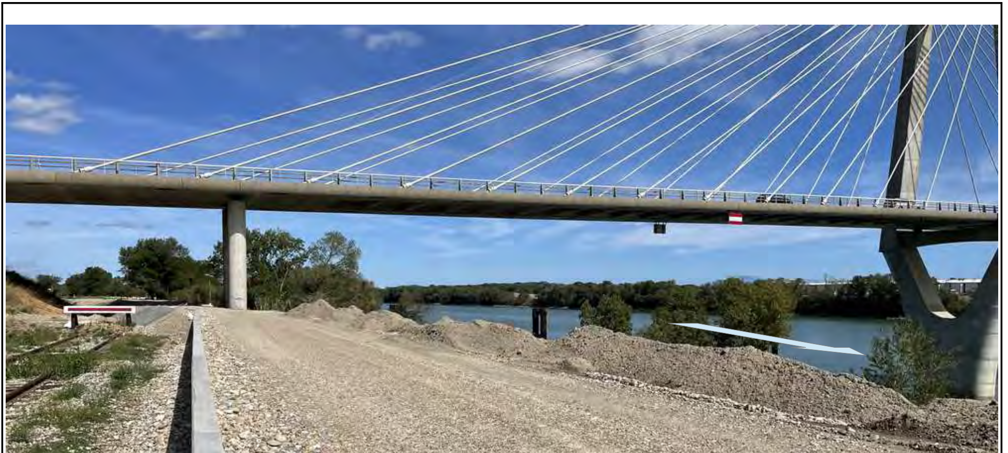
Photo N° 1 Vue du lit mineur du Rhône et de la rive droite en aval du pont de la RD90
